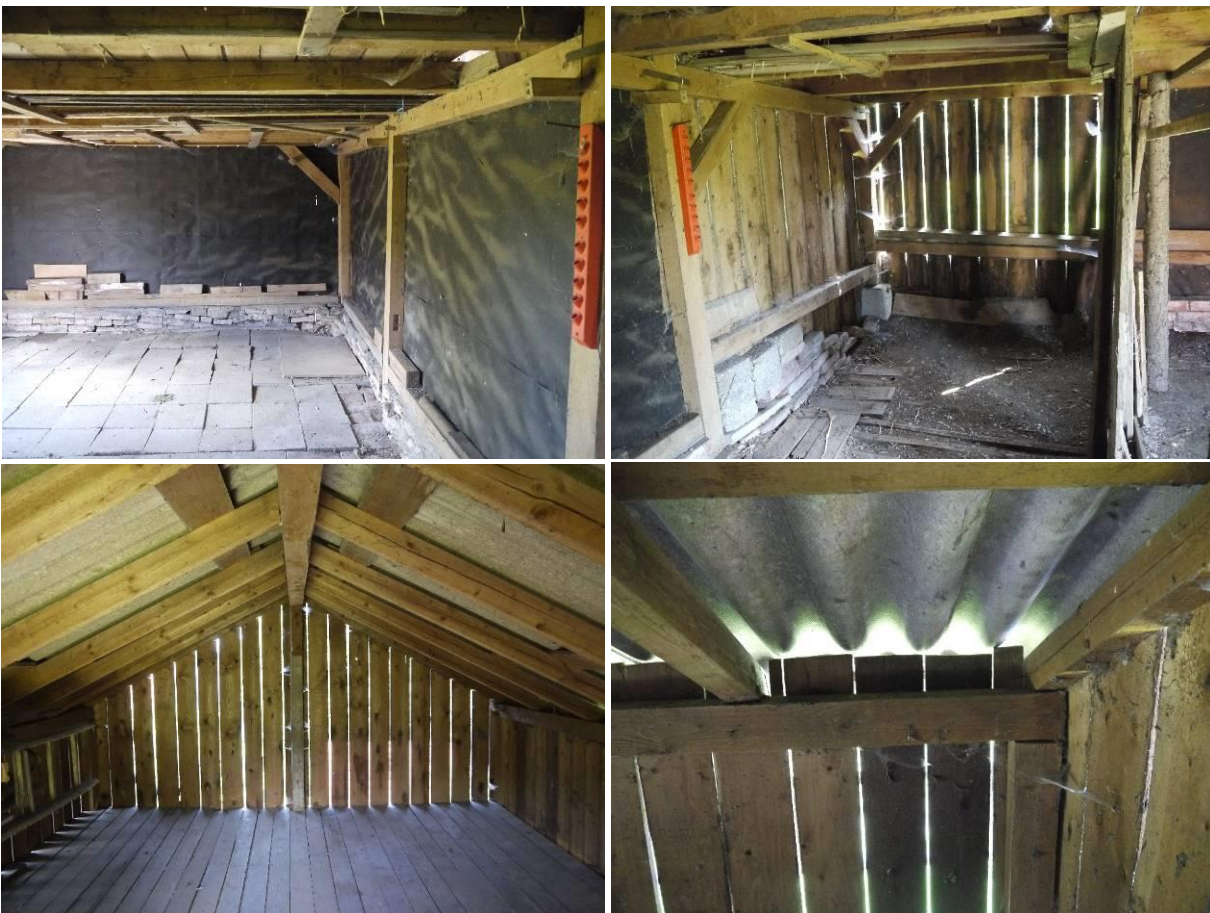
Abb. 11: Bilder aus dem Inneren des Schuppens. Deutlich zu sehen ist der Lichteinfall.
